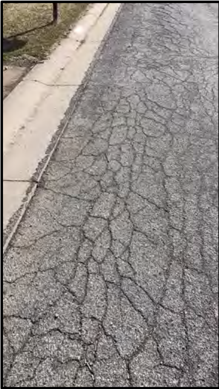
EDGE CRACKING
